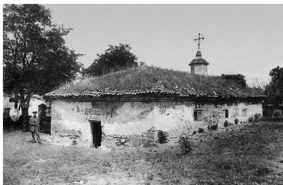
Biserica Adormirea Maicii Domnului din Căușeni (1924)
